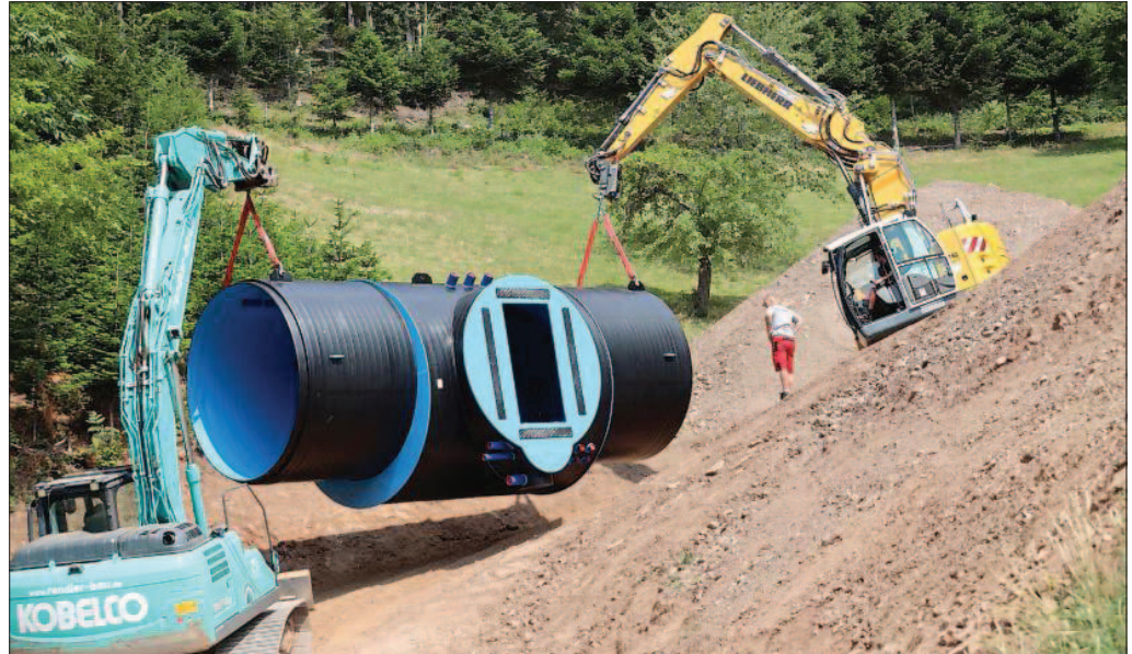
Mit zwei Baggern wird das größte Element im Steilhang nach oben geschafft. Foto: Bernhard Huber
