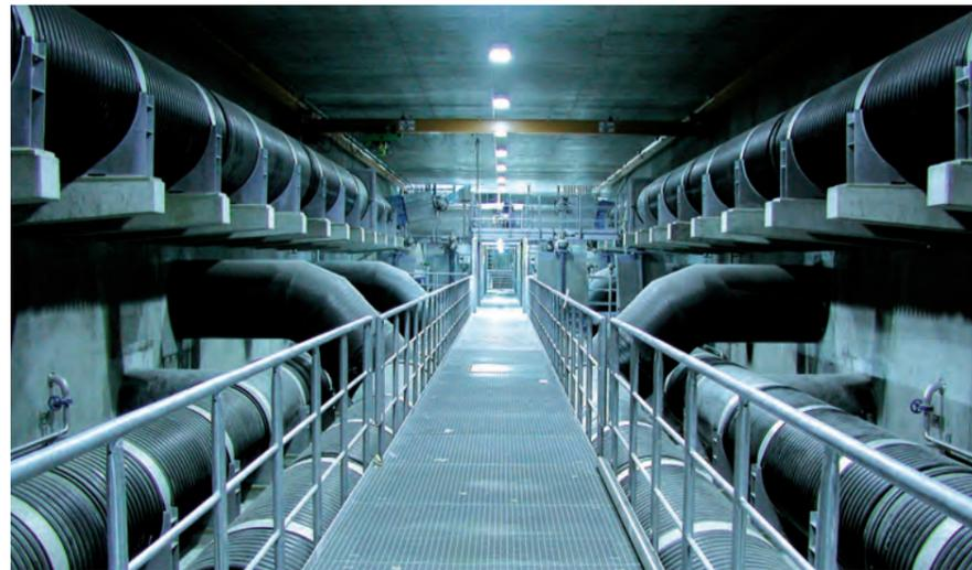
Druckrohrleitung – Ein- oder doppelwandige Druckrohrleitungen für den Transport großer Mengen Luft, Wasser oder sonstiger Medien. Die Verbindung der Wickelrohre wird dabei in der Regel durch eine Heizelementstumpfschweißung hergestellt.
