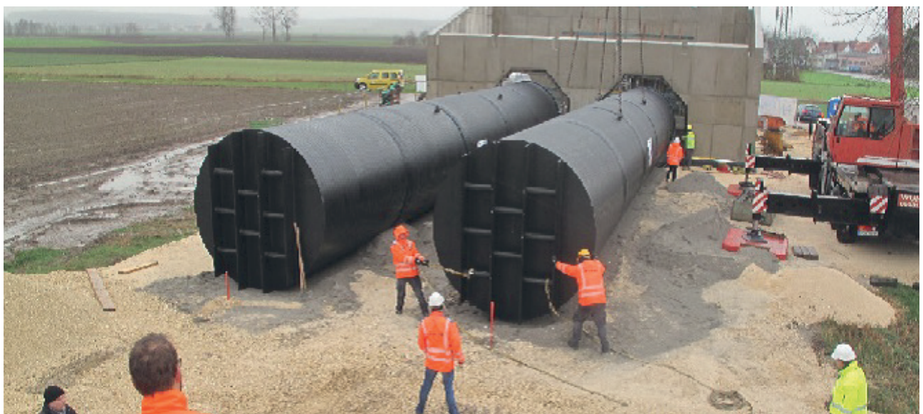
Bild 1: Versetzen der Röhrenbehälter auf vorbereitetes Auflager
