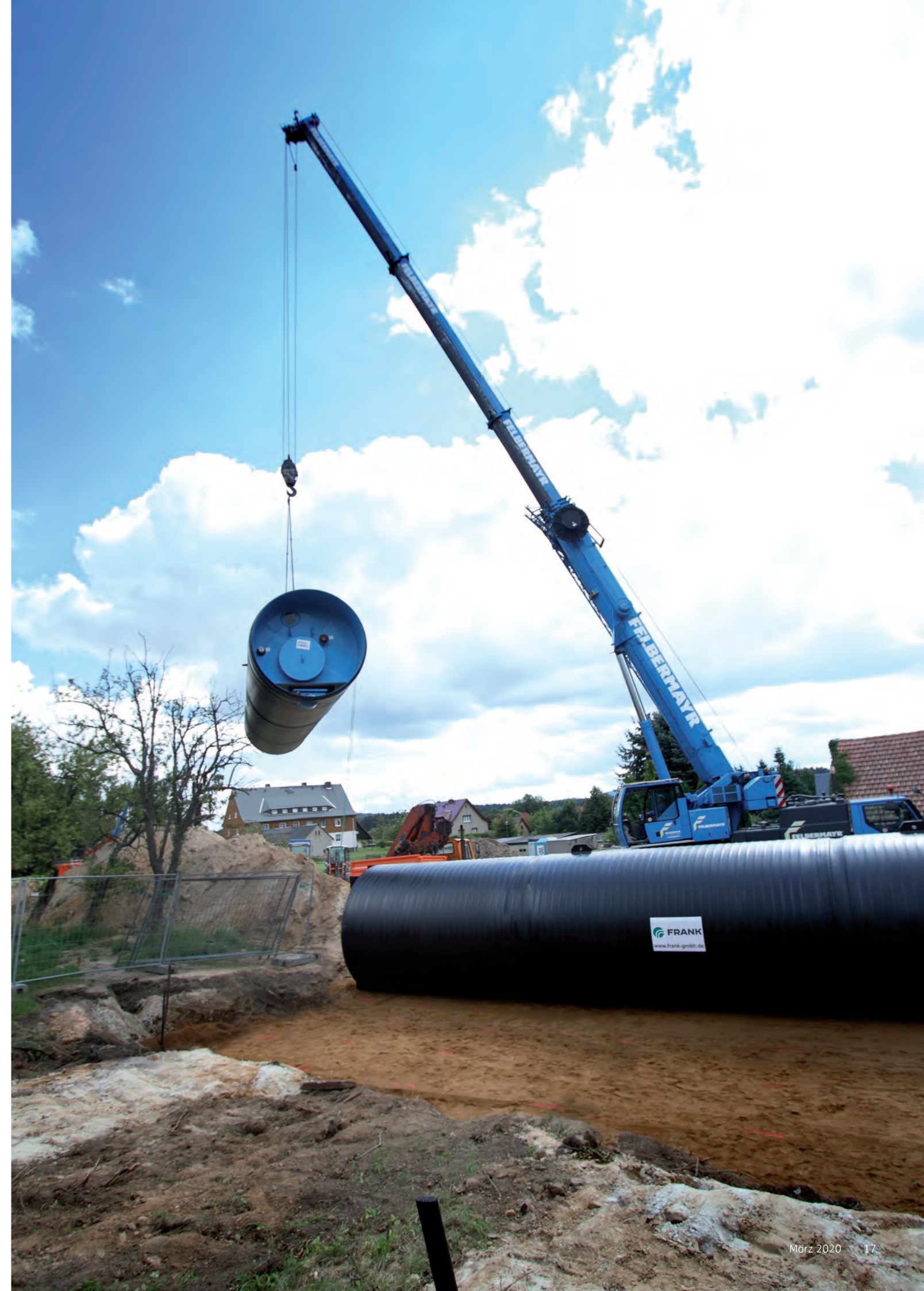
FTW®-Trinkwasserspeicher: Setzen eines Trinkwasserspeichers (DN 2700) inkl. Armaturenkommer
