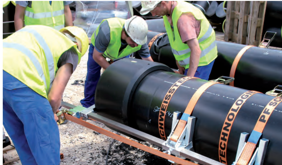
AGRU Heizwendelformteil im Einsatz
