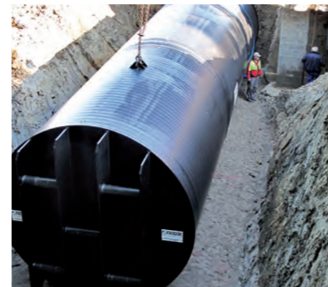
FTW®-Trinkwasserspeicher: Setzen eines Trinkwasserspeichers (DN 2700) inkl. Armaturenkommer
