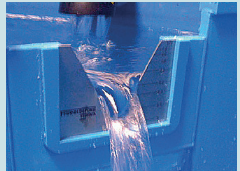
Messwehr zur Ermittlung der Schüttung in einem Quellsammelschacht
