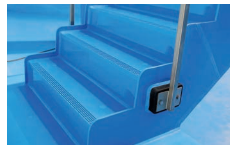
Auskleidung einer Betontreppe mit PE-Platten
