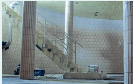
Vorher: Sanierungsbedürftiger gefliester Trinkwasserspeicher
