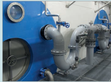
Betonbauwerk mit integrierten Wasserkammern aus PE 100
