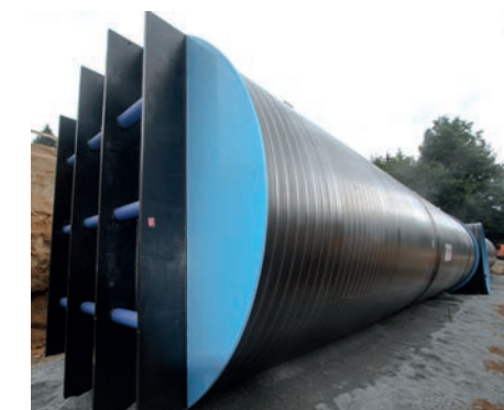
Wasserspeicher links und rechts angeordnet mit mittiger Armaturenkammer und Einstieg seitlich.
